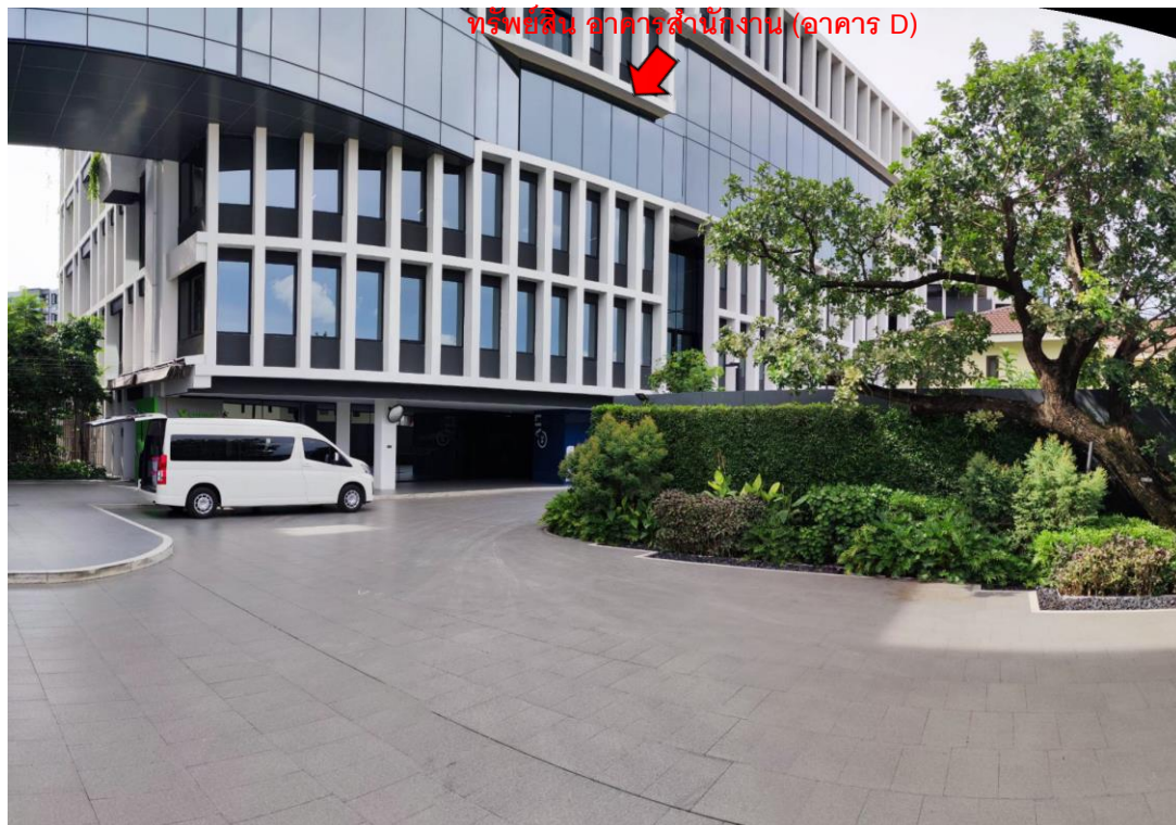
121. ภาพถ่ายบริเวณด้านหน้าที่ตั้งทรัพย์สินที่ประเมิน / สิ่งปลูกสร้างรายการที่ 4 อาคารสำนักงาน 6 ชั้น (อาคาร D)
