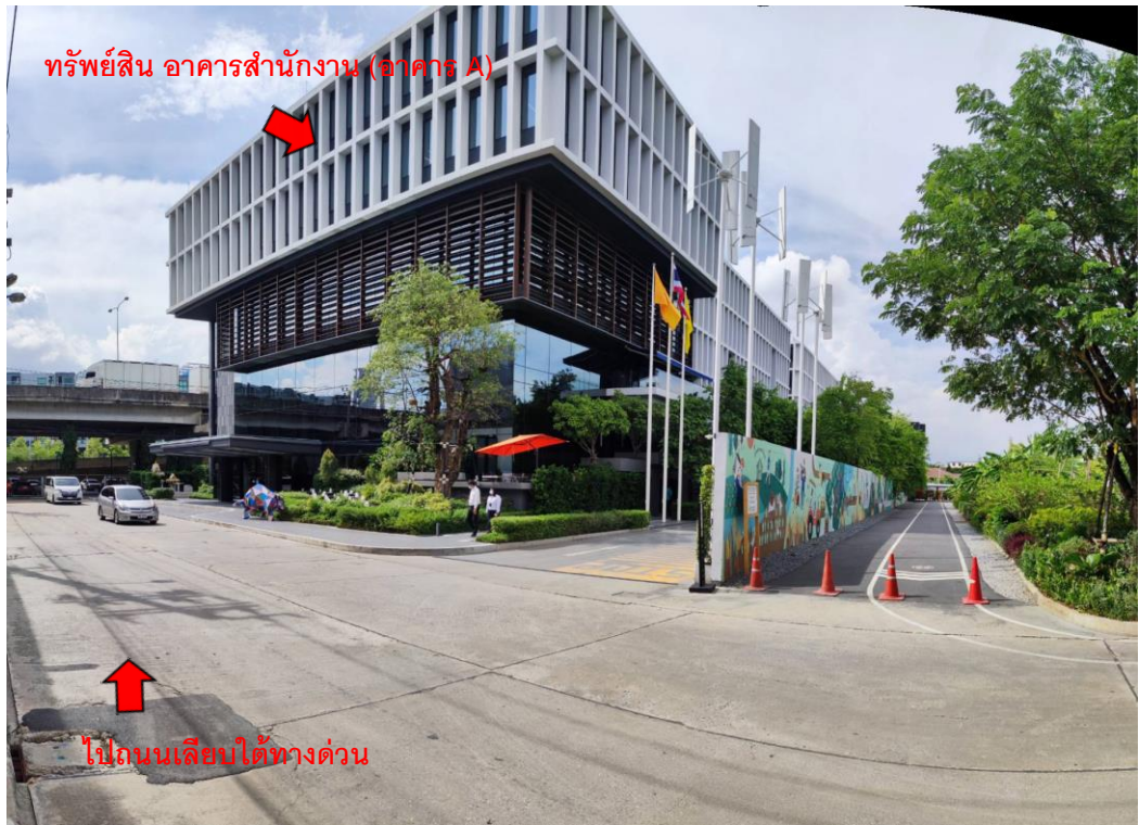
13. ภาพถ่ายบริเวณด้านหน้าที่ตั้งทรัพย์สินที่ประเมิน - ถนนโครงการ T77 (ถนนส่วนบุคคล)
