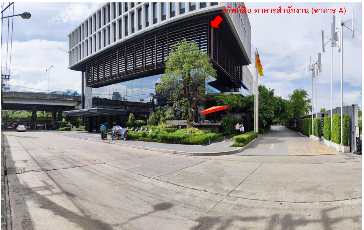
16.ภาพถ่ายบริเวณด้านหน้าที่ตั้งทรัพย์สินที่ประเมิน โครงการ SIRI CAMPUS สิ่งปลูกสร้างรายการที่ 1 อาคารสำนักงาน 6 ชั้น (อาคาร A)
