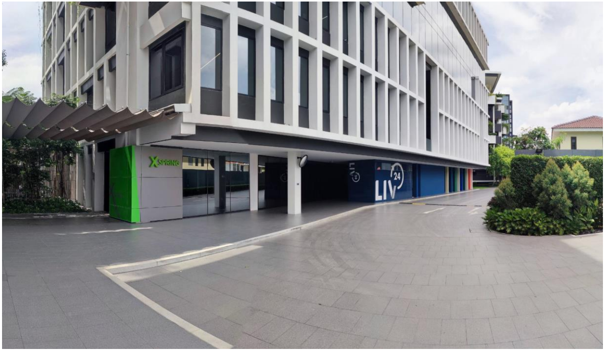
123. ภาพถ่ายบริเวณด้านหน้าที่ตั้งทรัพย์สินที่ประเมิน / สิ่งปลูกสร้างรายการที่ 4 อาคารสำนักงาน 6 ชั้น (อาคาร D)
