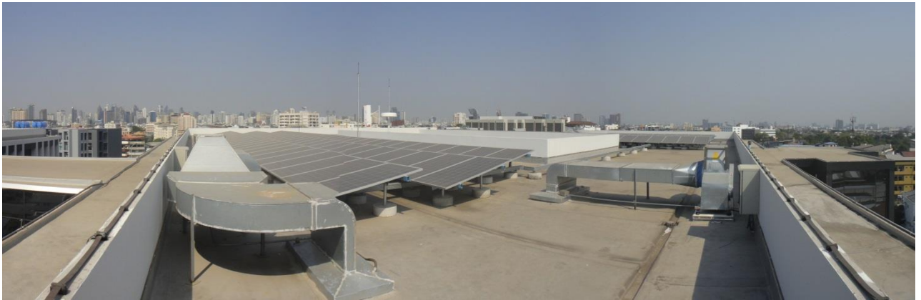
173. ภาพถ่ายภายในทรัพย์สินที่ประเมิน สิ่งปลูกสร้างรายการที่ 5 อาคาร E / บริเวณ ชั้น 7 ทางเชื่อมระหว่างอาคาร
